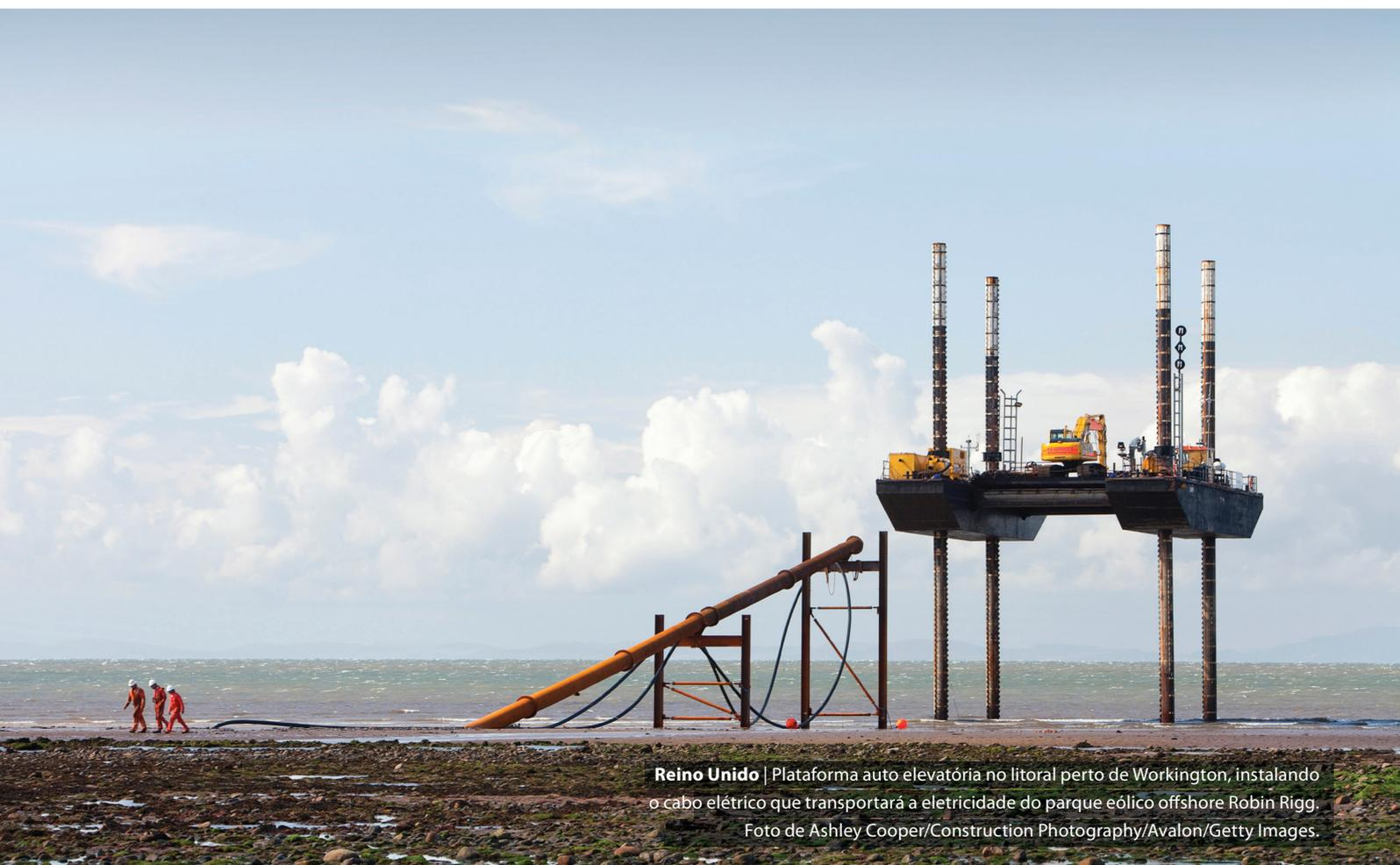
**Reino Unido** | Plataforma auto elevatória no litoral perto de Workington, instalando o cabo elétrico que transportará a eletricidade do parque eólico offshore Robin Rigg. Foto de Ashley Cooper/Construction Photography/Avalon/Getty Images.
